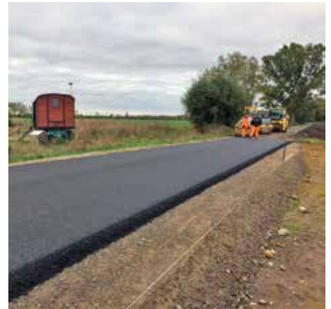
Foto: U. Büttner - Straßenbau zum Bodenordnungsverfahren in Neubarnim
